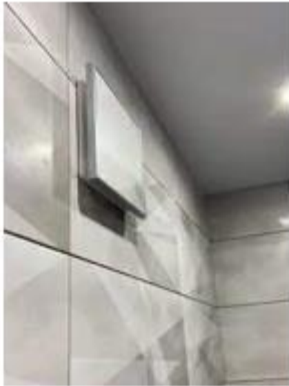
Рисунок 1.6 – Витяжні вентилятори у кухні та ванній кімнаті
