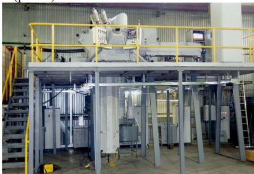
Рис. 1. Загальний вид електронно-променевої установки L4 для переплаву високочистих металів і сплавів
