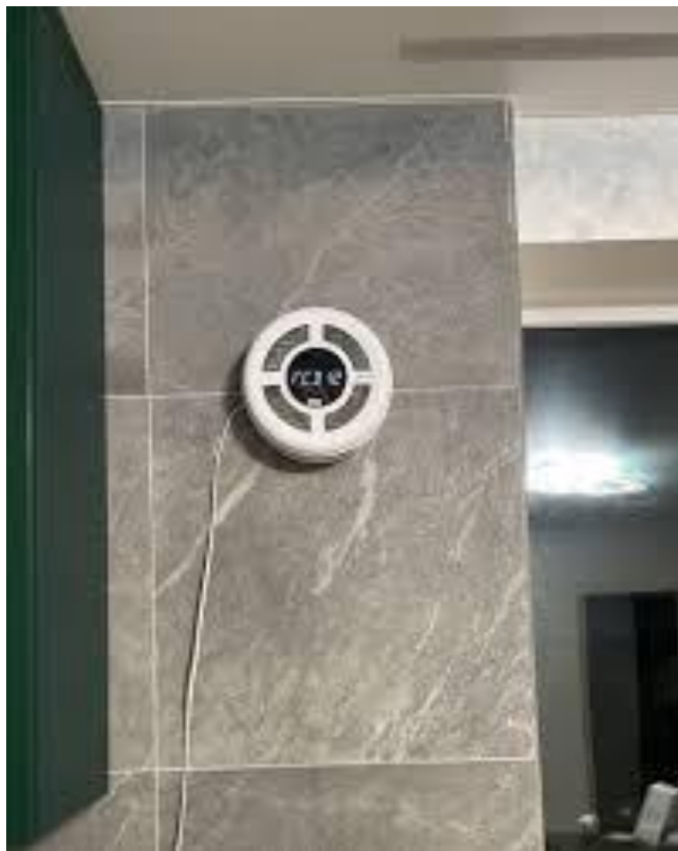
Рисунок 1.5 – Рекуператор
