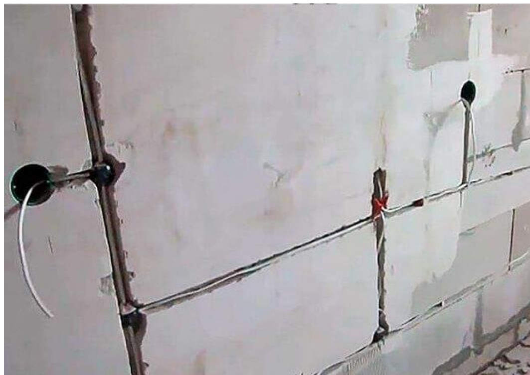
Рисунок 1.9 – Прокладання кабелю у штробах
