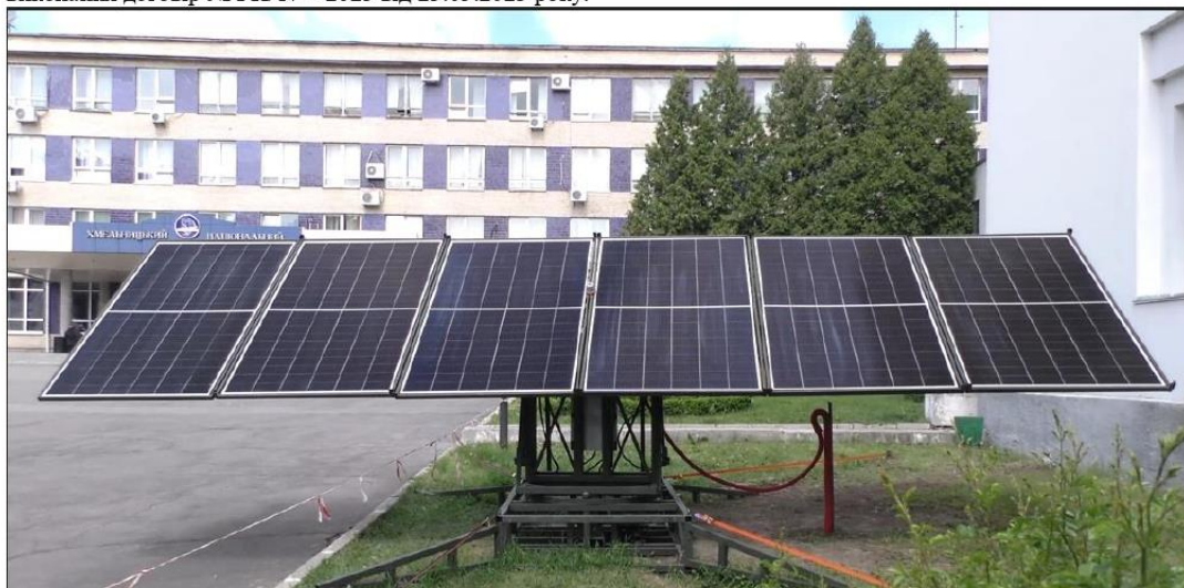
Рис. 1. Високоєфективна автономна система електроживлення установки переробки полімерних відходів у дизпаливо
