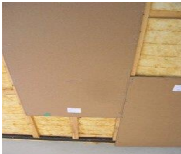
Рисунок 1.6 – Звукоізоляція стелі
