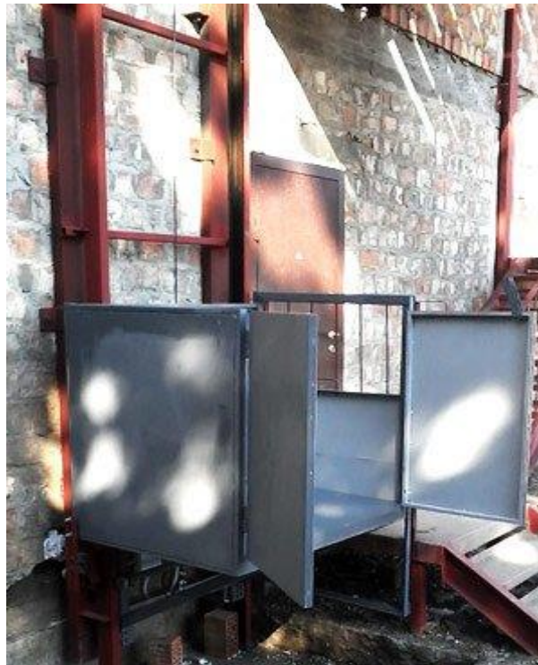
Рисунок 1.8 -Фасадний консольний підйомник
