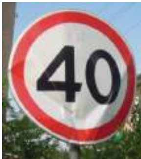
Рисунок 1.9 – Пошкоджений (деформований) дорожній знак [17]
