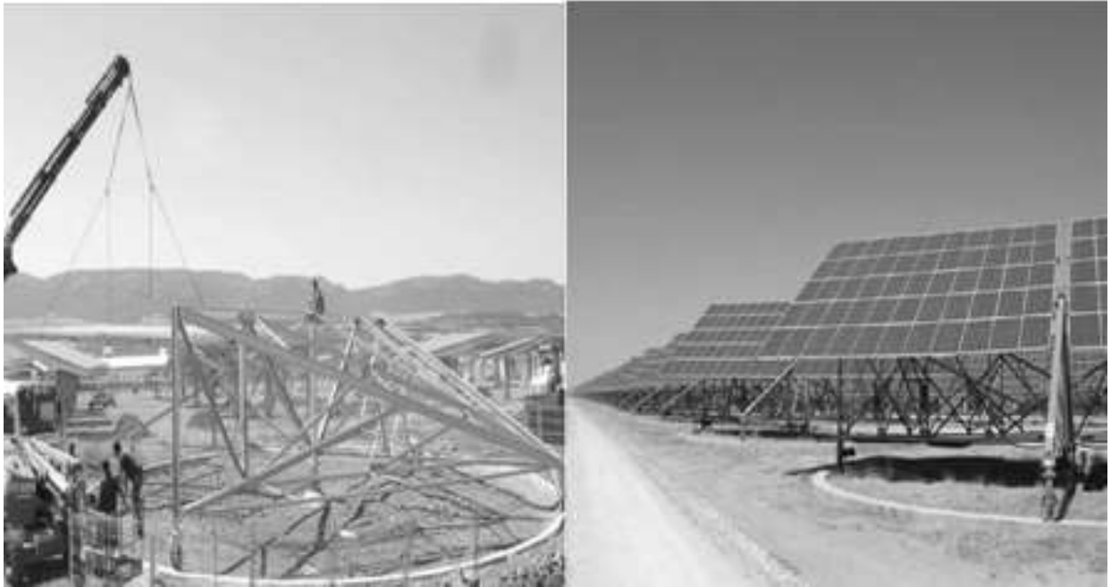
Рисунок 1.15 - Процес установки TITAN TRACKER (ліворуч) і загальний вигляд встановлених модулів (праворуч)
