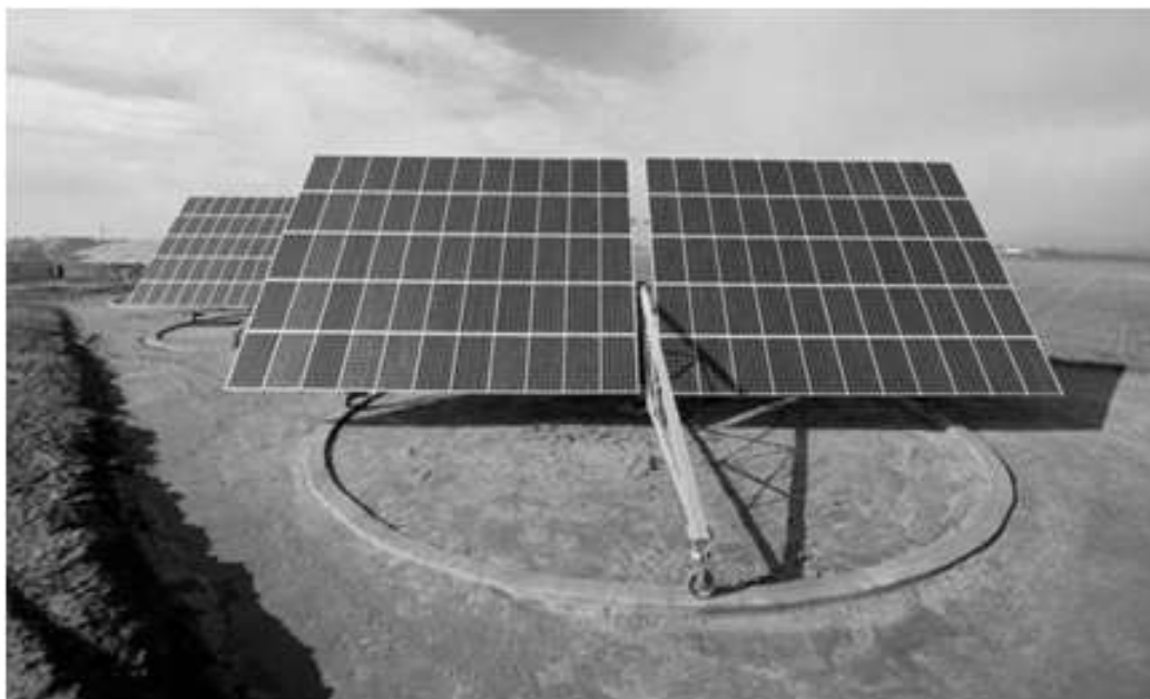
Рисунок 1.12 - Поворотний механізм автоматичного стеження за Сонцем TITAN TRACKER
