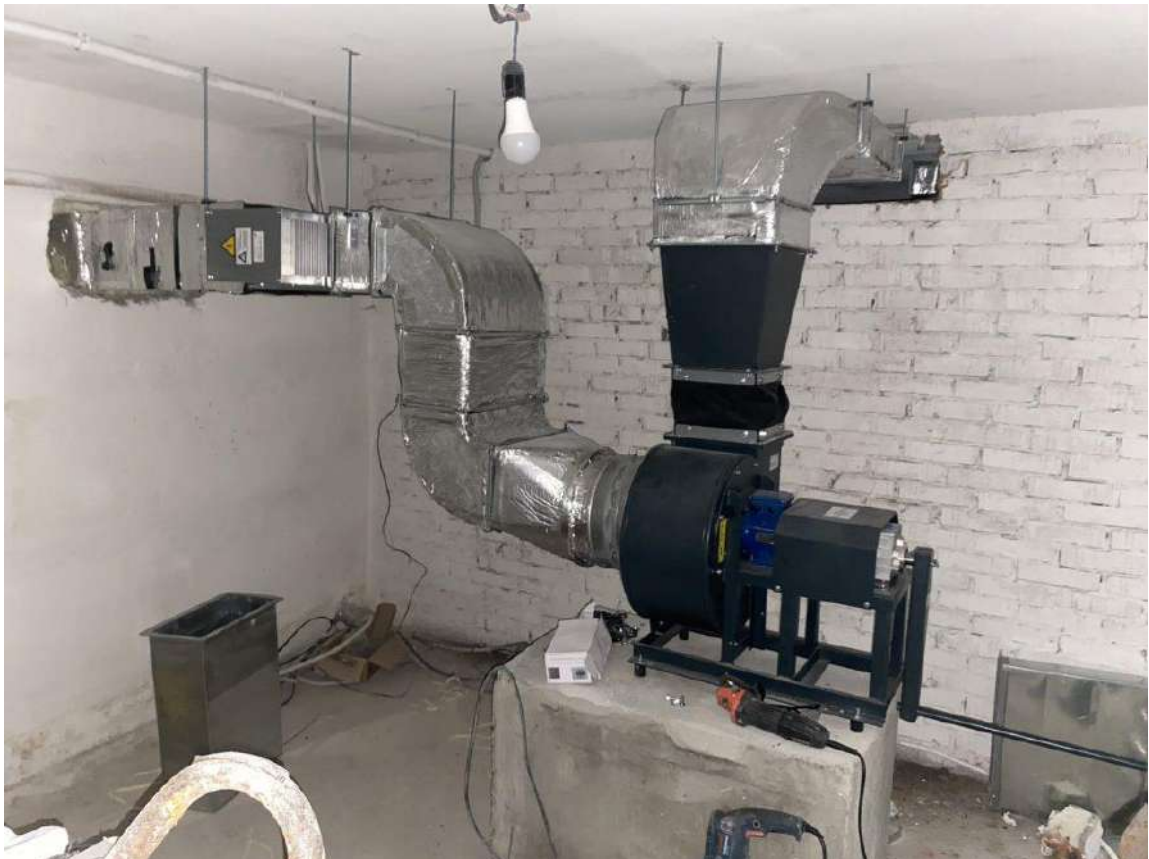
Рисунок 1.1 – Система вентиляції для укриття [4]
