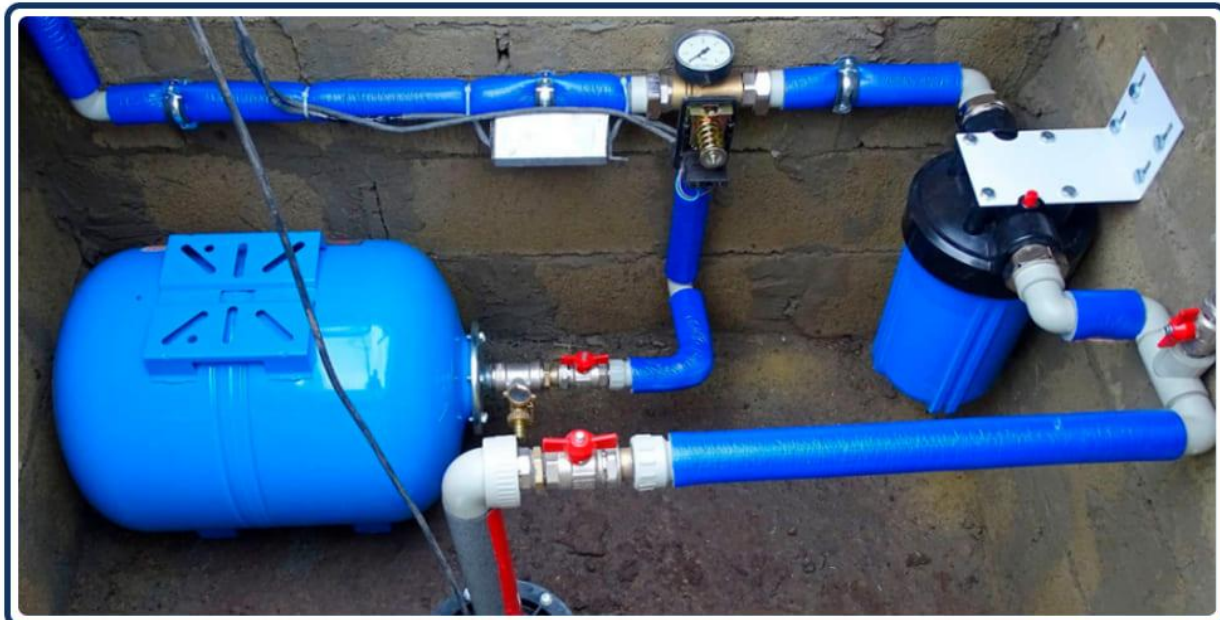
Рисунок 1.4 – Завершений варіант облаштування приямка (кесону) розглянутої системи [3]
