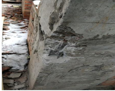
Рис. 1. Натурні обстеження конструкцій, ушкоджених корозією
