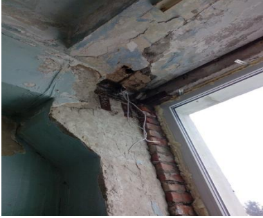
Рис. 1. Натурні обстеження конструкцій, ушкоджених корозією
