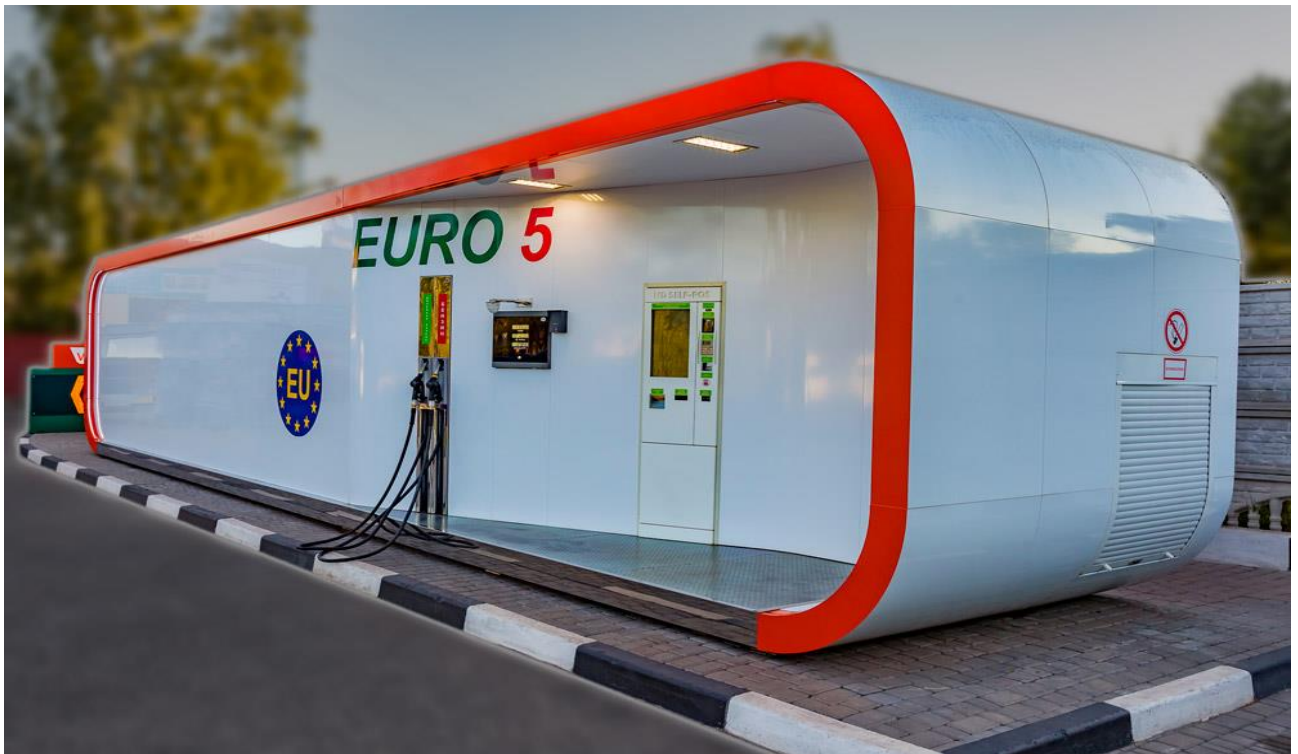
Рисунок 1.1 – Заправний комплекс контейнерної автозаправної станції Robotanks K4
