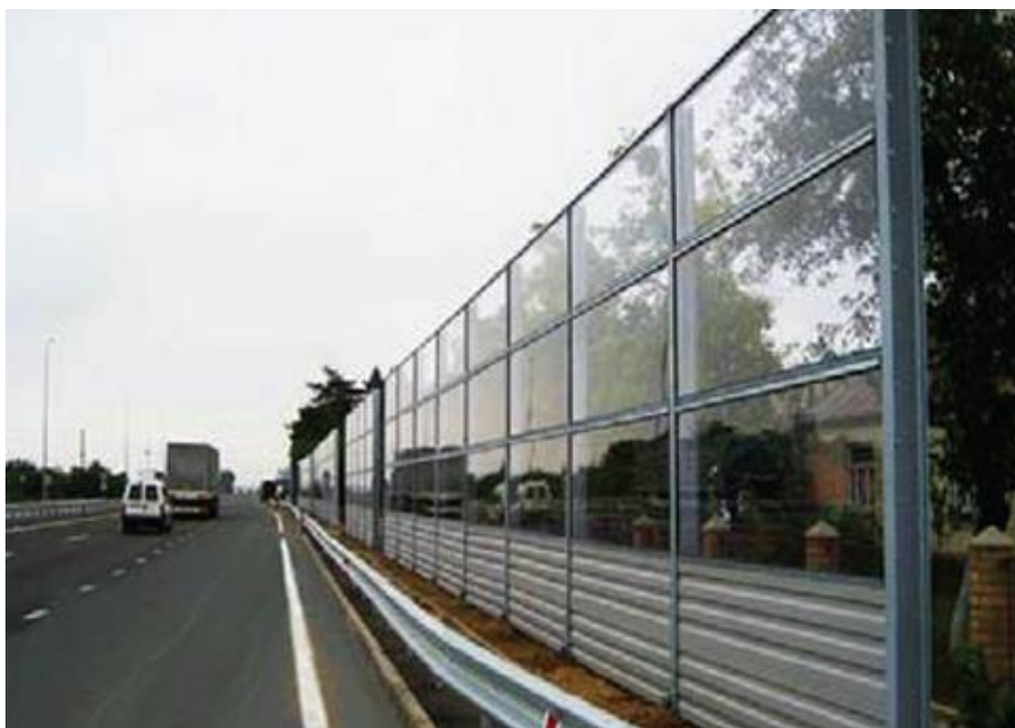
Рисунок 3.1 – Приклад встановлення акрилового екрану
