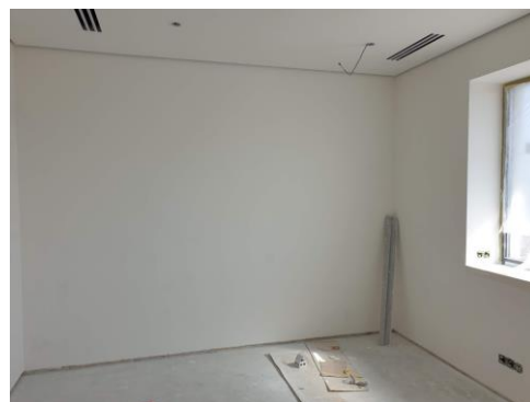
Рисунок 70 – Оздоблення стін в проекті котеджу
