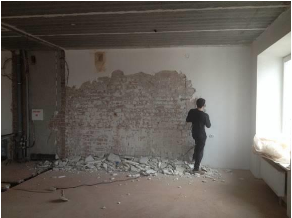
Рисунок 1.15 – Вигляд кафе під час ремонту
