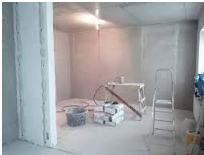
Рисунок 1.14 – Вигляд приміщення під час ремонту
