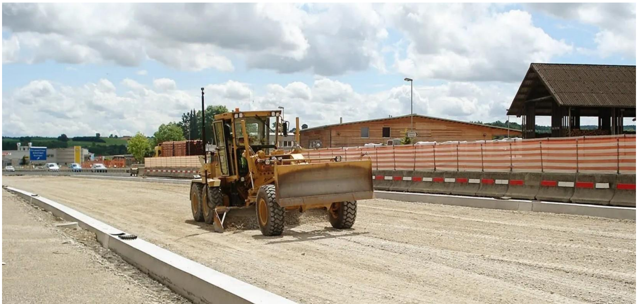
Рисунок 3.1 – Влаштування основи дороги з сипучих матеріалів з допомогою 3D – системи
