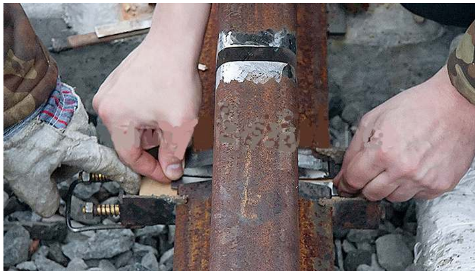
Рисунок 1.2 – Регулювання величини підйому стику рейок
