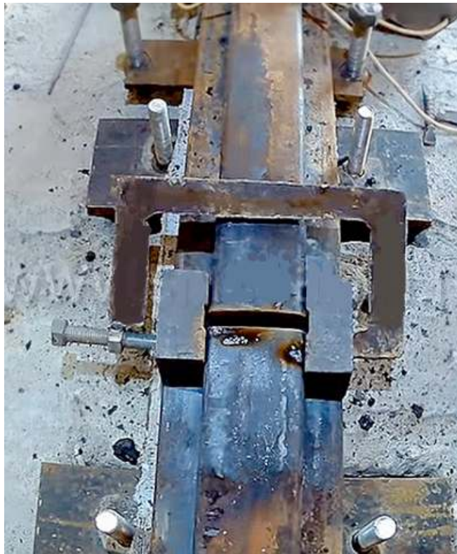
Рисунок 1.4 – Установка бічних форм.
