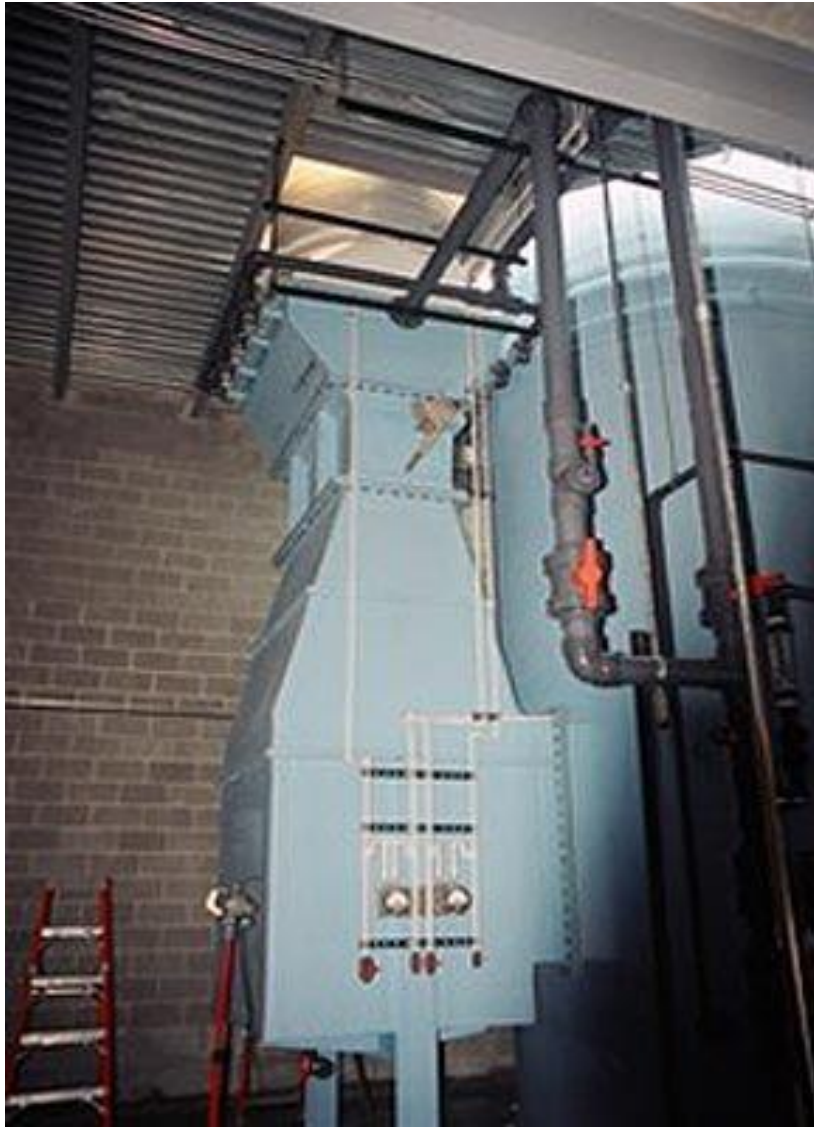
Рисунок 3.2 – Скрубер Venturi (виробник RITM industry, Україна)
