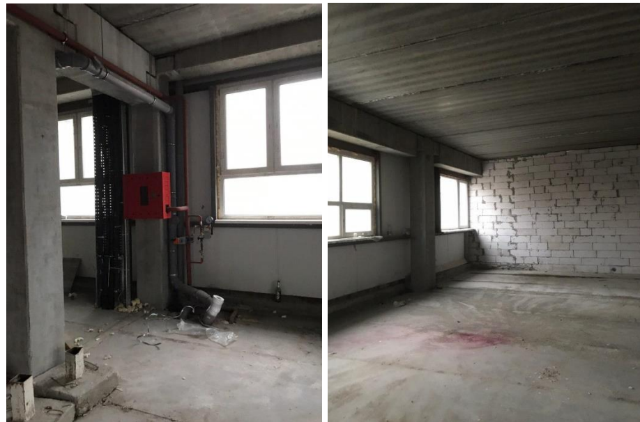
Рисунок 1.4 – Стан існуючого об'єкта обраного приміщення
