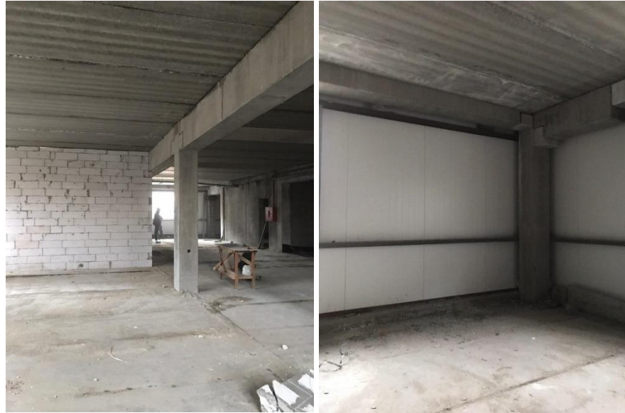
Рисунок 1.3 – Стан існуючого об'єкта обраного приміщення
