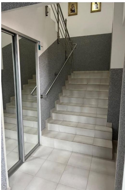
Рисунок Б.9 – Гардеробна та сходи після ремонту
