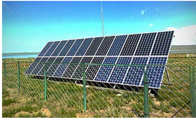
Рисунок 1.11 – Енергетична установка University Malaysia Sarawak
