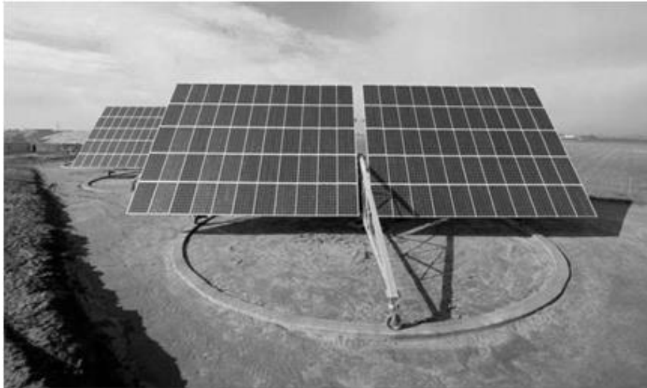
Рисунок 1.10 - Поворотний механізм автоматичного стеження за сонцем TITAN TRACKER
