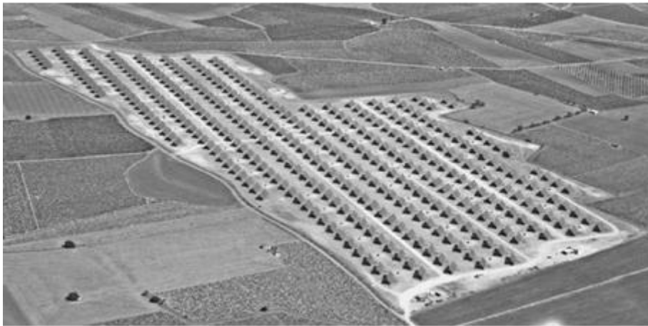
Рисунок 1.14 - Вигляд зверху геліоелектростанції на основі модулів TITAN TRACKER
