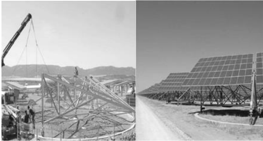
Рисунок 1.13 - Процес встановлення TITAN TRACKER (ліворуч) та загальний вигляд встановлених модулів (праворуч)
