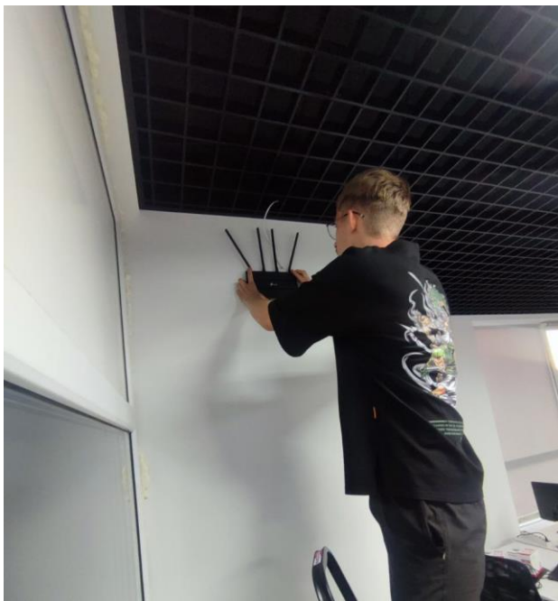
Рисунок 3.8 – Встановлення точки доступу
