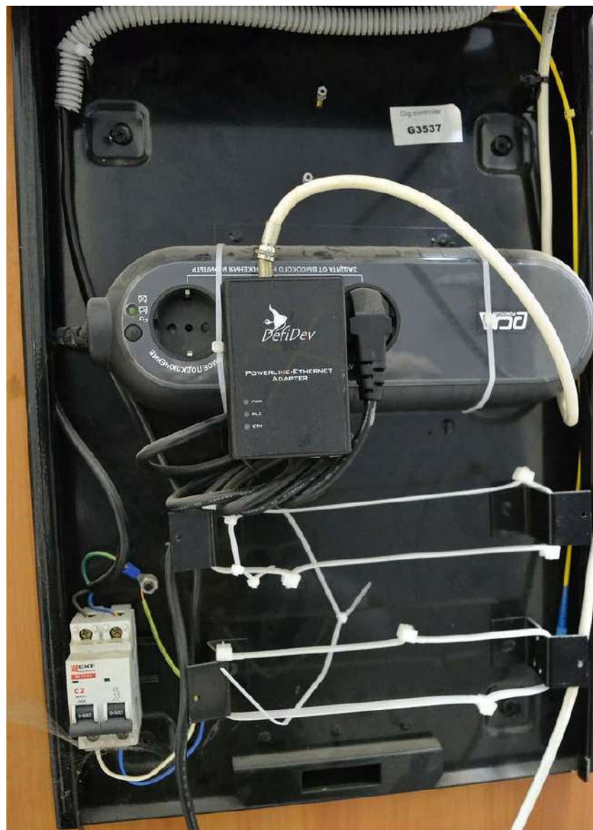
Рисунок 2.11 – Приклад практичного монтажу передатчика стандарту PLC
