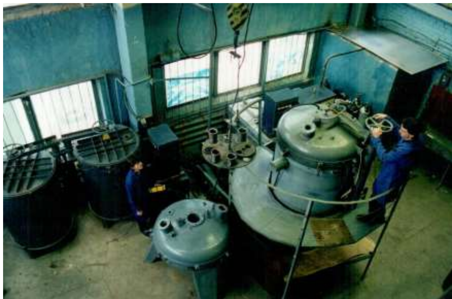
Промислова установка для іонного безводневого азотування
